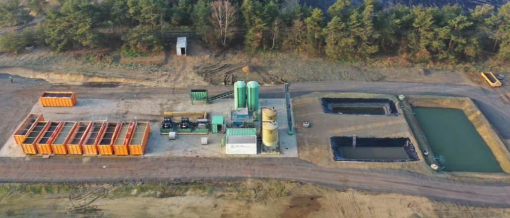
MUDCLEANER Station Entsorgungszentrum Borg im Landkreis Uelzen
